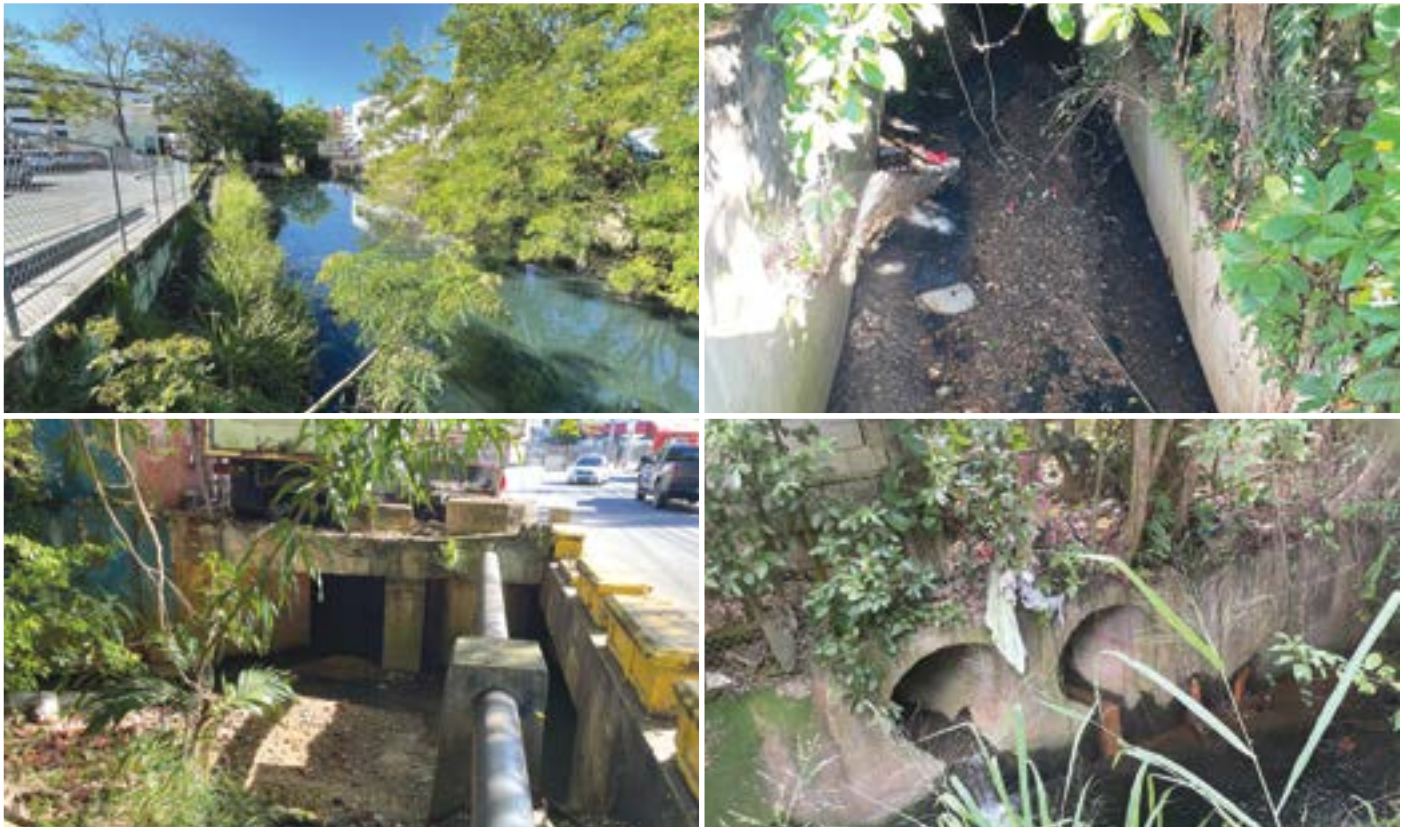
Figura 6. Modificaciones de canalización a lo largo de la QJM. Arriba a la izquierda: rectificación y ensanchamiento (al lado del Centro de Diagnóstico y Tratamiento Dr. Enrique Koppish, San José); arriba a la derecha, profundización (cerca de la intersección entre la calle de Diego y la calle Cabo Máximo Alomar); abajo a la izquierda, cierre (cerca de la intersección entre las calles de Diego y Cabo Máximo Alomar); y abajo a la derecha, tuberías descargando agua en la QJM, comunidad Buen Consejo (Fotos tomada por S. Burgos, el 3 de enero de 2024 y el 3 de julio de 2024).
