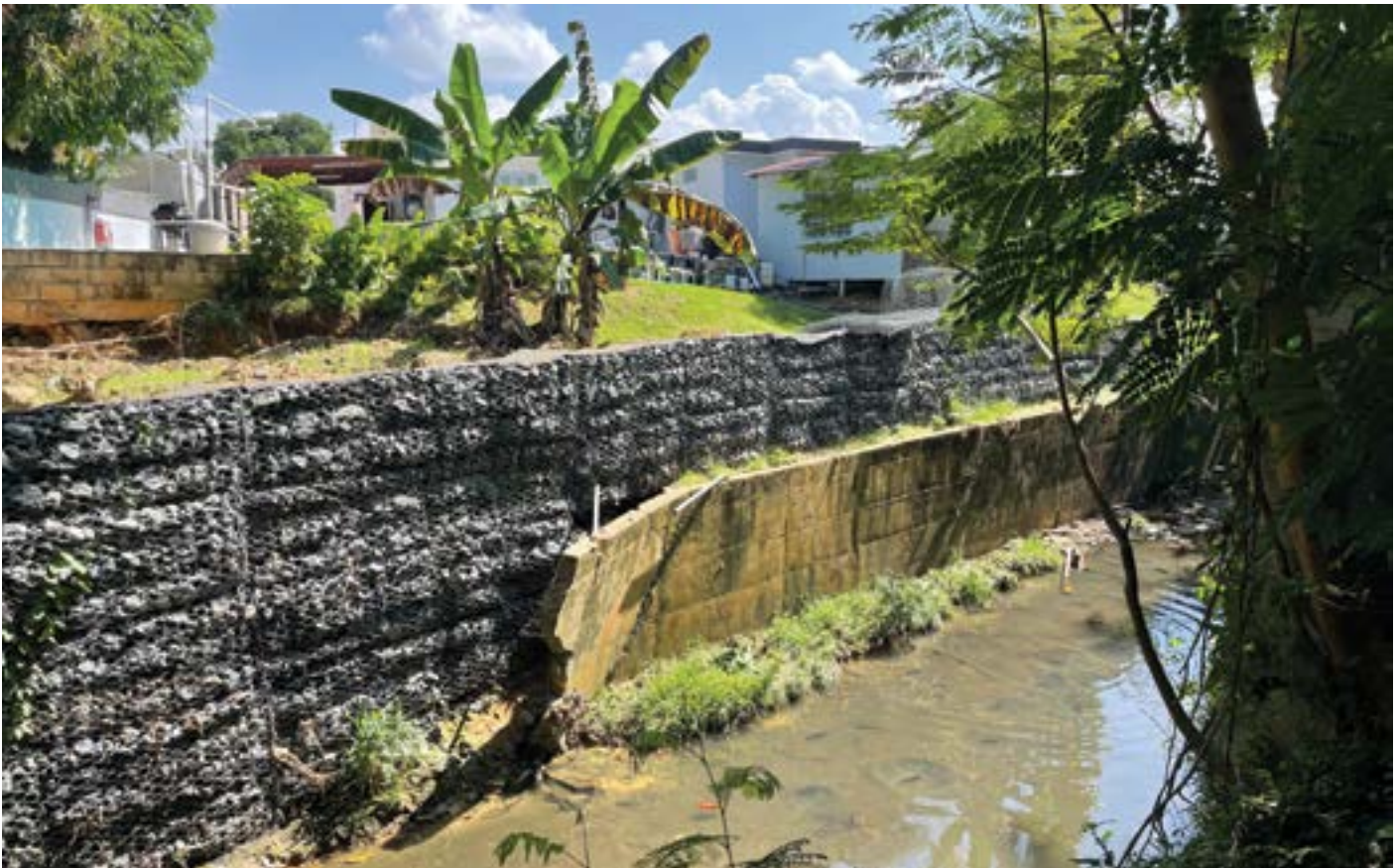
Figura 9. Muro de gaviones instalado en parte de la QJM donde la pared del canal ha colapsado (Foto tomada por S. Burgos, 1 de agosto del 2024).
