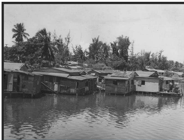
Arabal La Playita, formado por 42 casas, en el margen sur de la Laguna del Condado (1955).
