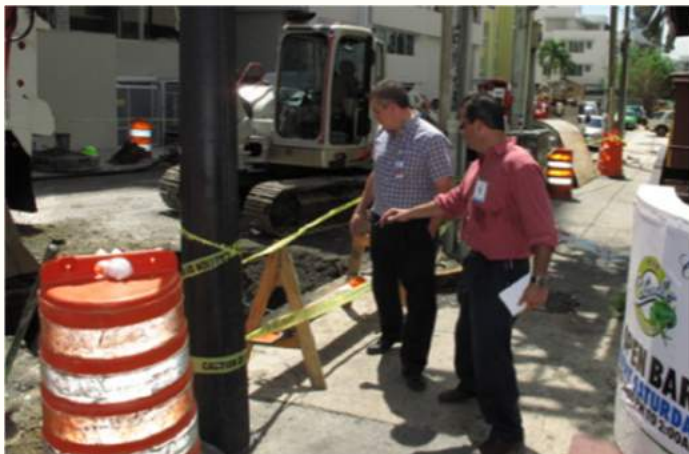
Figura 4. Juan Carlos Pérez de la JCA y el Dr. Jorge Bauzá-Ortega del PEBSJ inspeccionando obras de mejoramiento del sistema de alcantarillado sanitario en la Calle Mayagüez, Laguna del Condado.
